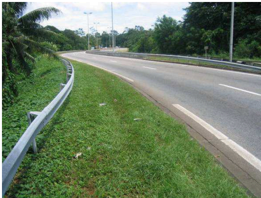
Photo 21 : Carrefour des Maringouins, source Egis
