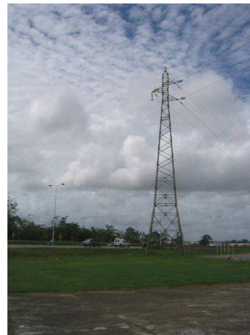
Photo 24 : Réseau électrique- station fixe de Cayenne, source Egis
