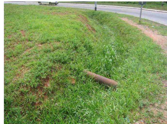
Photo 22 : Réseau d'assainissement présent sur l'aire d'étude, source Egis
